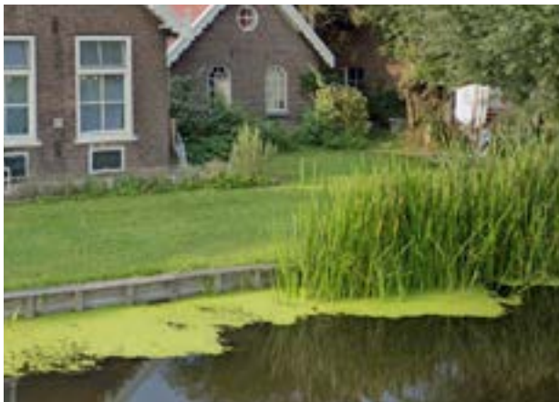
Oeverbeschoeiing met plasdras berm
